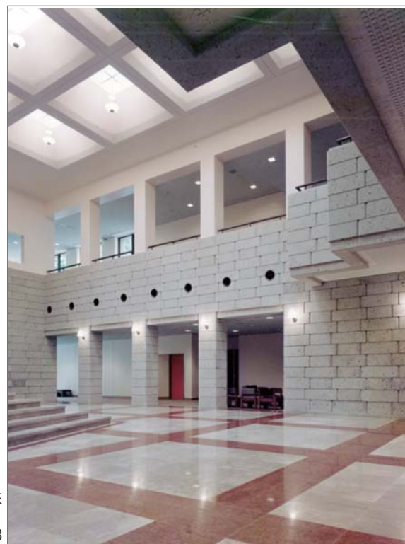
市は1Fの大谷石の列柱の間に、自動扉のガラスサッシを計画している。エントランスホールの奥行きが失われるとともに、2Fの列柱と合わせたデザインが破壊される。（右）写真-13
