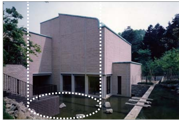
池の全域（点線箇所）がエレベーターシャフトと階段室になり、全破壊される。写真-8
